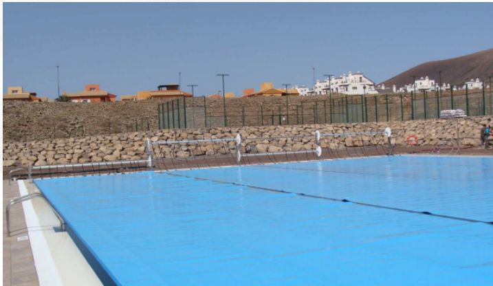
Cobertura em Processo de Enrolamento
